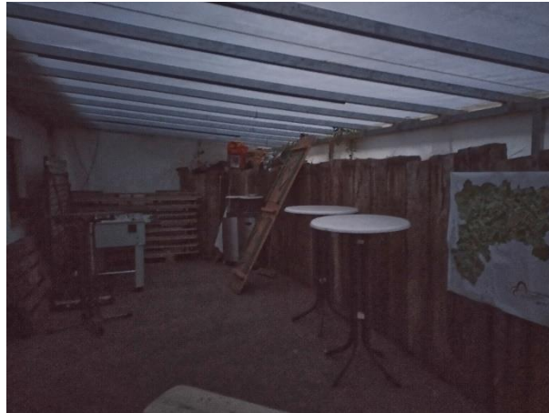
Überdachter Bereich hinter dem Bürgerhaus mit stinkenden, ggf. toxischen Bahnschwellen
